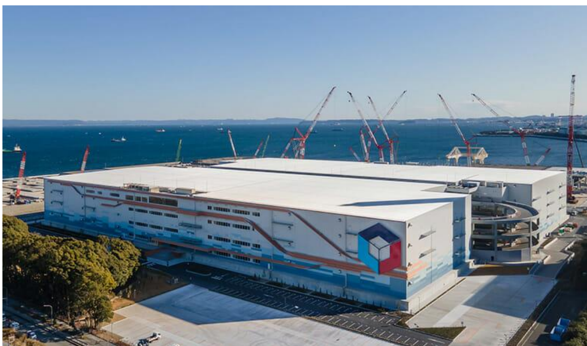
Hình 6: Trung tâm logistics Yokohama Sachiura Logistics Park tại Nhật Bản
