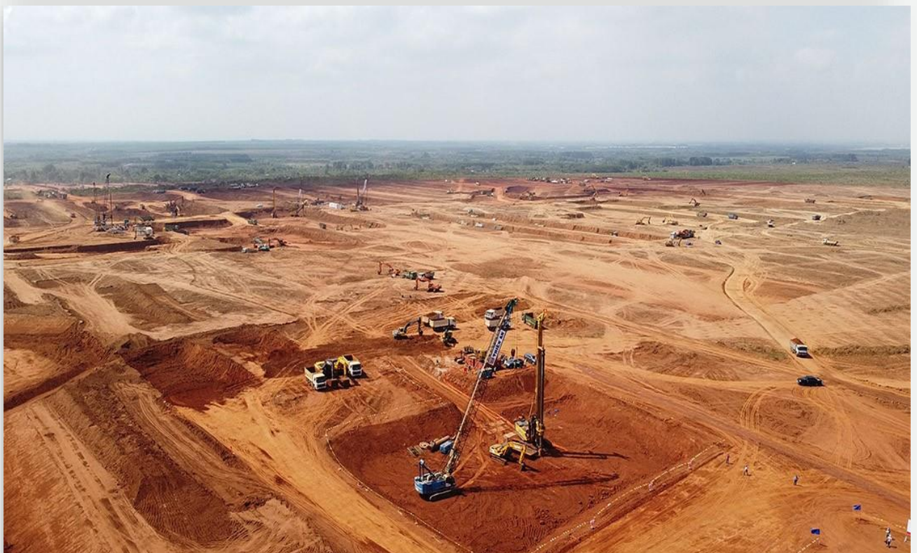
Mặt bằng thi công tại dự án sân bay Long Thành
